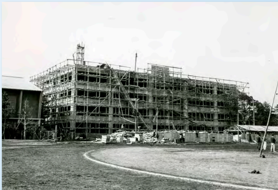
1957(昭和32)年頃 5号館(体育学部校舎)建設風景
