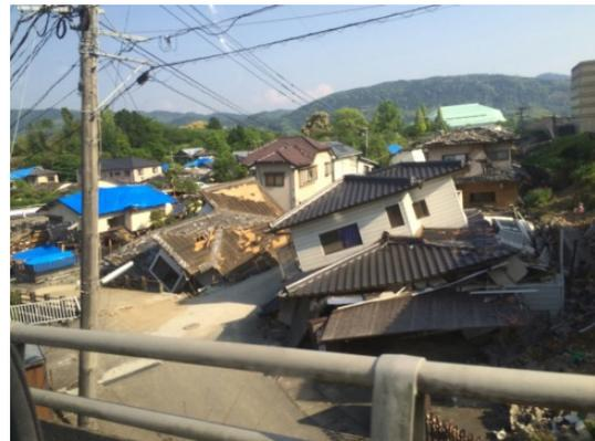
写真 4 倒壊した家屋
