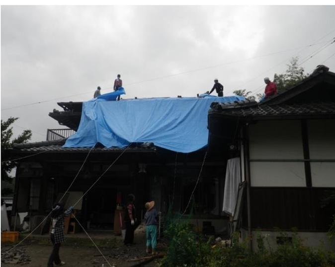
瓦礫の除去を行い、崖崩れが進行しないように、ブルーシートをかけている様子
