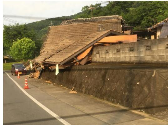
写真 3 倒壊した家屋
