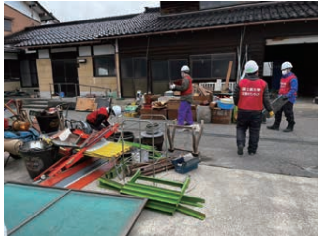
被災家屋からの運び出し
