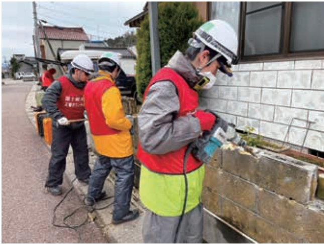
ブロック塀の撤去 2
