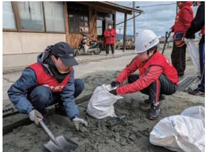
液状化で堆積した土砂の撤去
