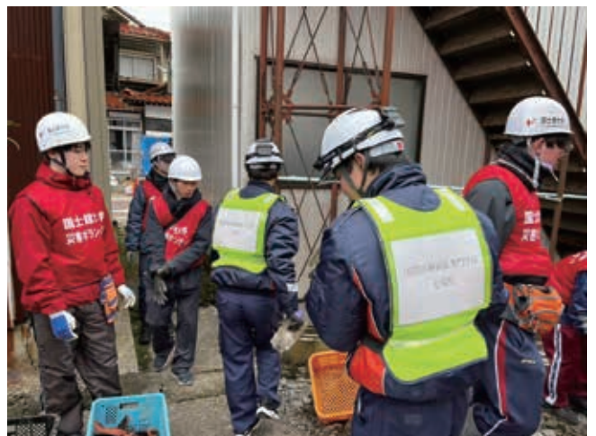
ブロック塀の撤去 2
