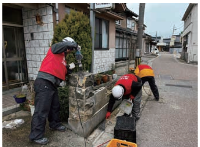
ブロック塀の撤去 1
