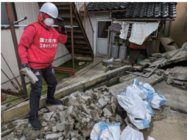
ブロック塀の撤去
