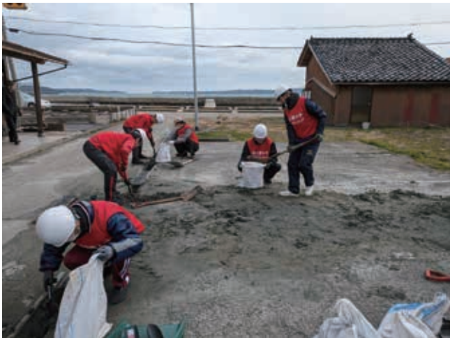
液状化で堆積した土砂の撤去
