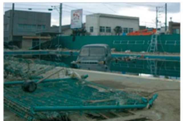
(写真5 プールの中に土砂が流れ込んでいる様子)
