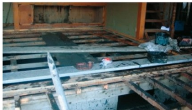
写真1：床板をはがして泥だし
