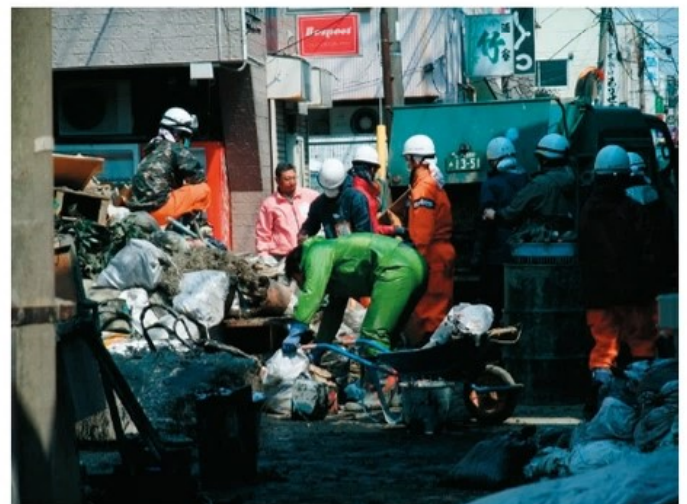
石巻の商店街のヘドロの入った土嚢を トラックに積み込んでいる様子
