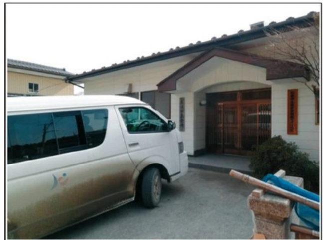
図 5 避難所として使用されていた公民館 石巻市避難所リストでは詳細不明となっていた。
