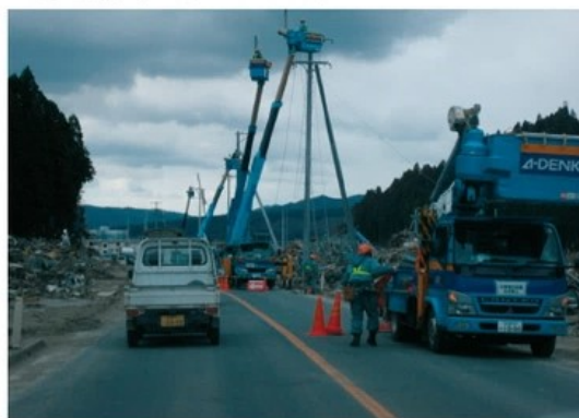
写真1：電気復旧工事の様子
