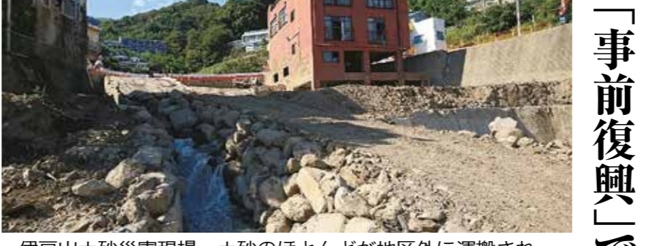
事前復興の一環として、静岡県焼津市花沢地区の石垣修復に学生とともに携わる。文化庁・文化財保存協会・自治体に対し、石垣修復の施工方法を説明する橋本教授(令和2年10月撮影)
